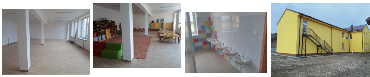
"Výstavba materskej školy v Pečovskej Novej Vsi na parcele KN-C č. 1471/22" ukončená v 2/2018
