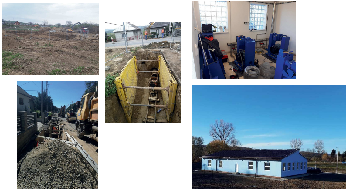
"Petrovany - kanalizácia" ukončená v 11/2018
