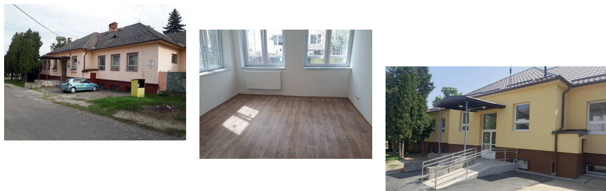
"Rekonštrukcia a modernizácia Komunitného centra Kráľovský Chlmec" ukončená v 4/2018
