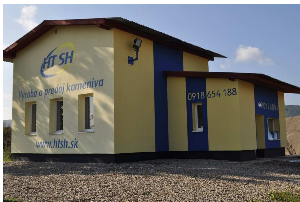
Prevádzková budova po rekonštrukcii v r. 2014
